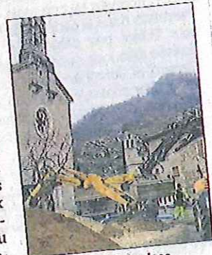
Gros travaux sur la place du village.
